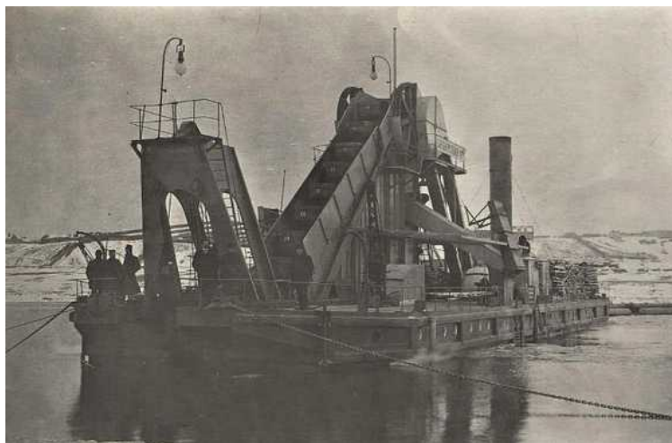
Рис. 3. Землечерпательница «Сибирская-11». Испытания на р. Туре. 1913 г. (Госкаталог № 28588277)
